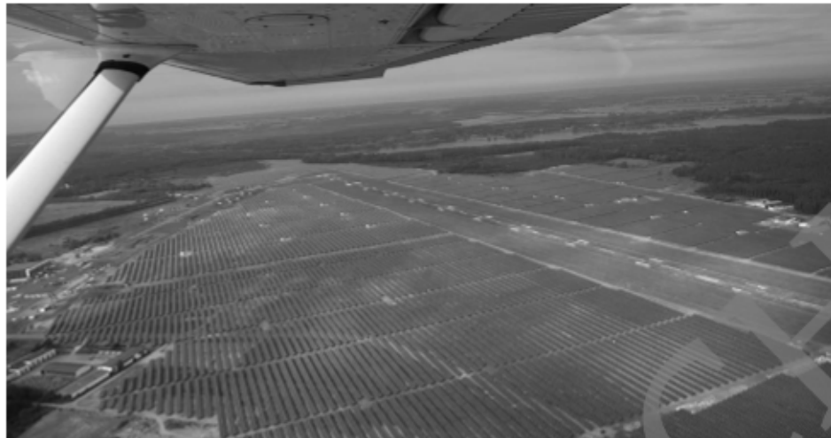
Solkraftwerk Neuhardenberg, 142 MW
