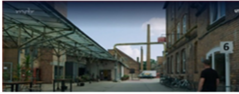
7 Das soziokulturelle Zentrum „Telux“ in Weißwasser
